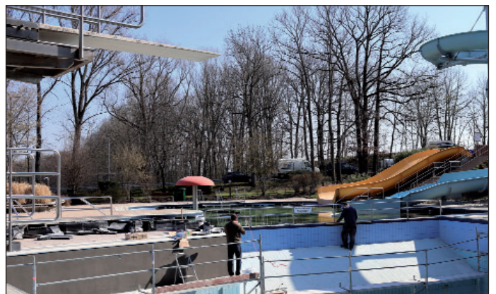
Fliesenarbeiten am Sprungbecken im Bad Mannichswalde
